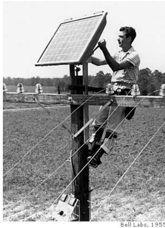
**Figura 1: Primeira utilização de placas fotovoltaicas aplicadas a uma rede telefônica. Fonte: [2]**
