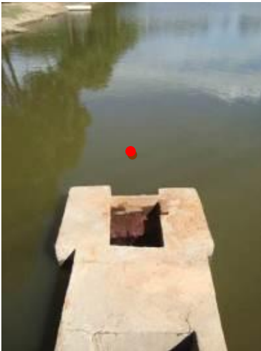
Figura 4: P3 – Vertedouro (primeira lagoa). Fonte: Autor do Trabalho.
