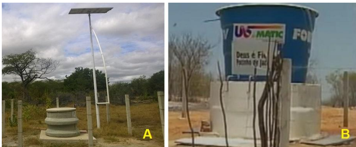
Figura 1: Imagens da estrutura do projeto no Sítio Juá, São João do Sabugi-RN, 2015. A - Estrutura do projeto do poço artesiano movido a energia solar; B – Reservatório para armazenamento da água do poço. Fonte: Autores do Trabalho
