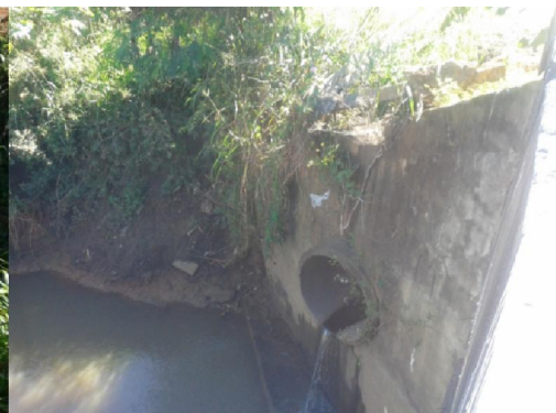
Figura 3- Despejo de esgoto industrial no córrego Palmito. Fonte: Marinho, 2015.
