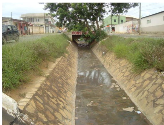
Figuras 2A e 2B. Vista parcial do canal principal mostrando um trecho localizado na parte superior do bairro (2a) e outro trecho (2B) mostrando o lançamento de esgoto no canal principal no período seco.
