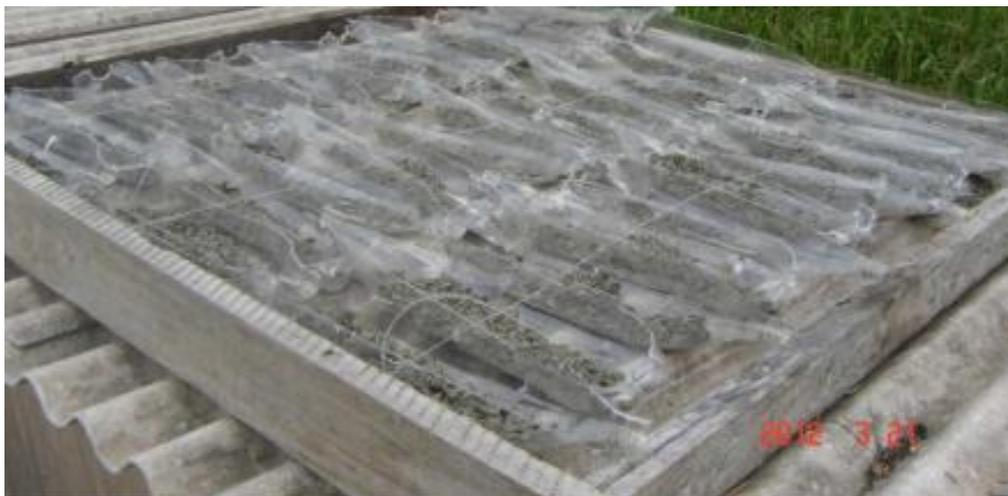
Figura 3: Módulos de telhado verde com garrafa pet.
