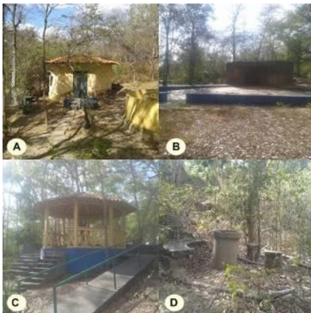
Figura 2: Equipamentos que estão danificados e/ou subaproveitados. Fonte: Autor do Trabalho.
