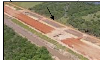
Foto 3. Vista aérea do local em novembro de 2011. A seta indica a localização da passagem de fauna em construção no local
