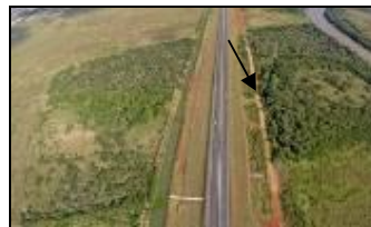
Foto 5. Fotografia mostrando o local em maio de 2014, após a inauguração da rodovia.
