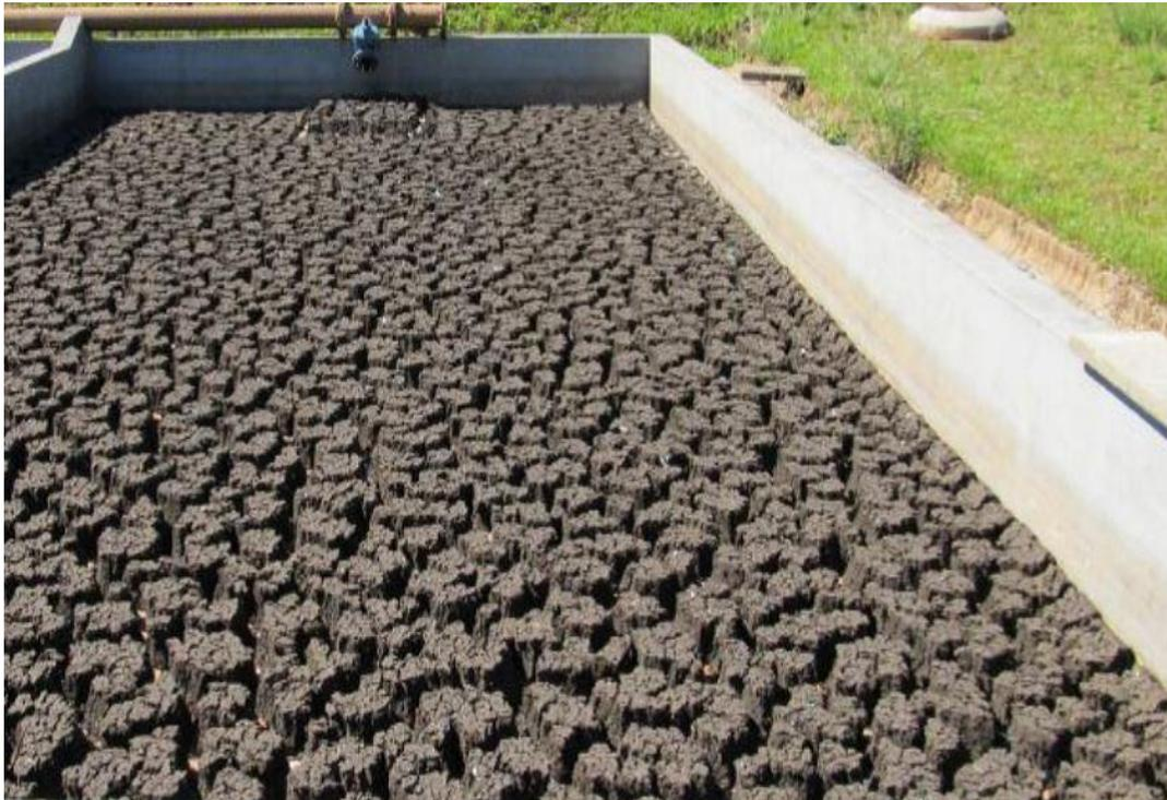
**Figura 1: Leito de secagem do lodo de esgoto gerado na estação de tratamento do esgoto. Fonte: Sanepar (2015).**
