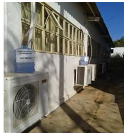
(1c) Esquema da coleta da água de drenagem do ar condicionado.
