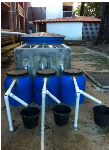
Figura 3: Medição da vazão dos filtros.
