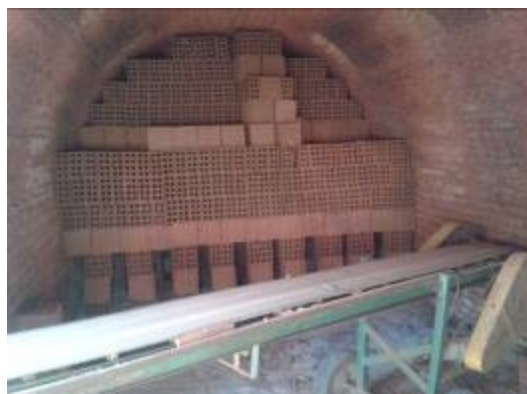
Figura 3: Tijolos Empilhados no Interior do Forno.
