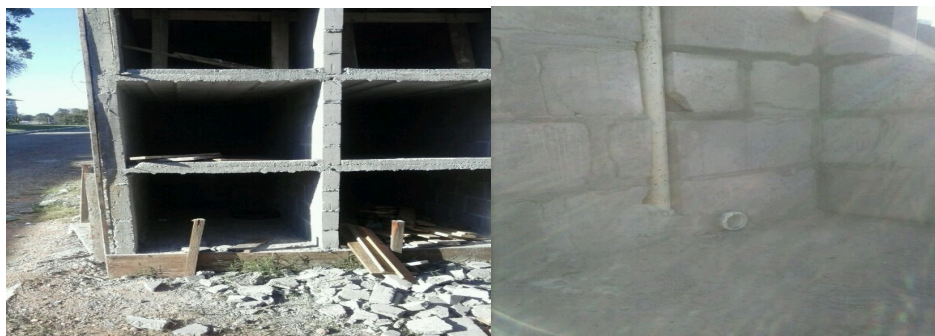
Figura 3. Túmulos verticais (a esq.) e tubos coletores do necrochorume dos jazigos verticais(direita) ambos do Cemitério Parque Bom Jesus de Cuiabá, Cuiabá-MT.
