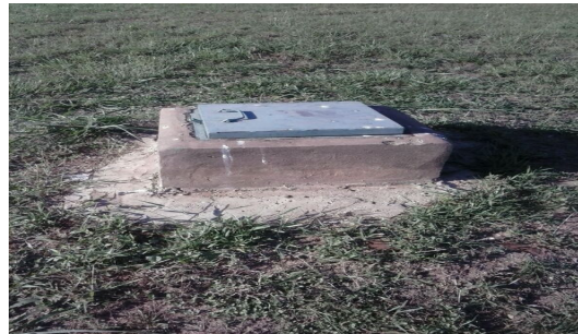
Figura 2. Poço de monitoramento do Cemitério Parque Bom Jesus de Cuiabá, Cuiabá-MT.
