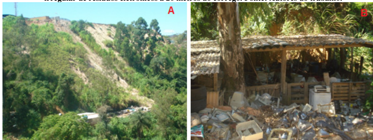
Figura 3: A) Movimentação irregular de terra no Distrito Industrial Jardim Piemonte. B) Disposição irregular de resíduos eletrônicos a 20 metros do córrego. Fonte: Autores do trabalho.
