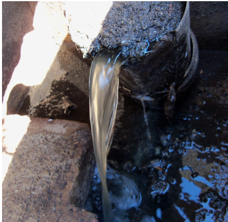
Figura 4: Efluente da saída do biodigestor. Fonte: Autor do Trabalho.
