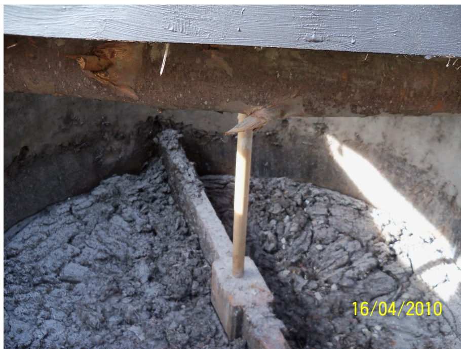
Figura 1: Crosta superficial formada no biodigestor. Fonte: Autor do Trabalho.
