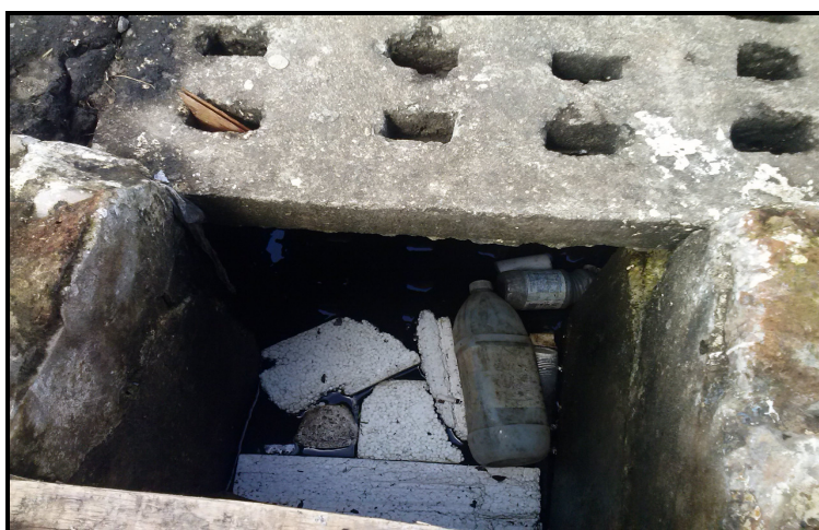
Figura 1: boca de lobo obstruída por resíduo sólido Fonte: Os autores, 2014.
