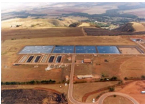
Figura 2: Vista aérea da ETE Recanto das Emas. Fonte: CAESB, 2014
