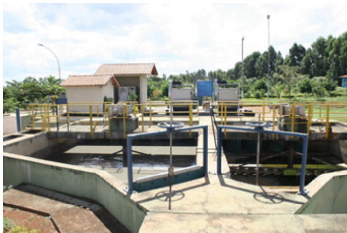
Figura 3: Vista do tratamento preliminar. Fonte: CAESB, 2014
