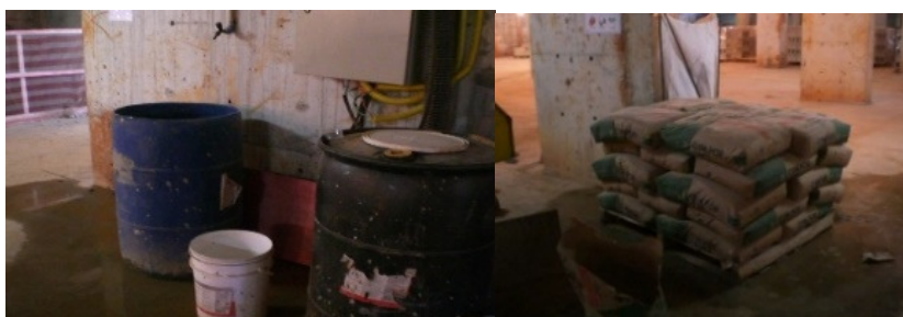
Figura 7: água de reuso e cimento. Fonte: Case CRV Construtora
