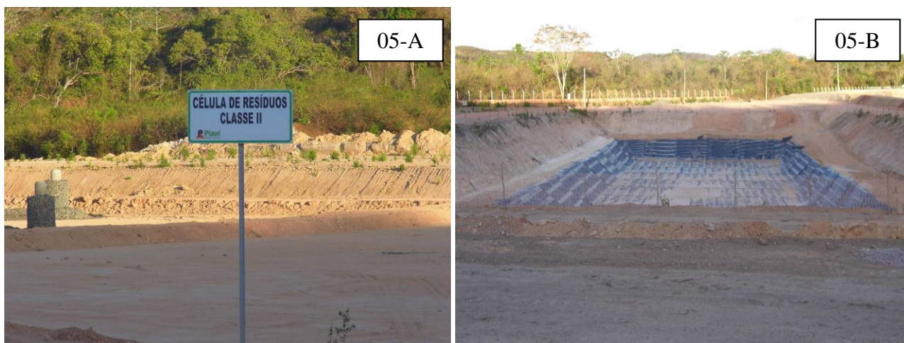
Figura 05-A Identificação de resíduos dispostos; 05-B vala preparada com manta impermeabilizante para disposição de resíduos. Fonte: Autores, 2014.
