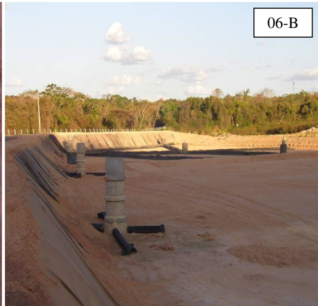
Figura 06 A e B Poços de monitoramento nas valas de aterro na CTR de Altos-PI. Fonte: Autores, 2014.
