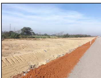
Figura 5: Camada de areia sobre os resíduos.
