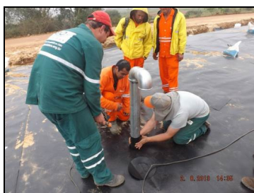
Figura 7: Instalação dos drenos de gás.
