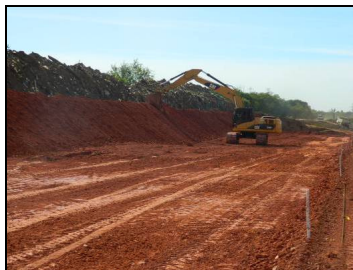
Figura 2: Compactação da base.
