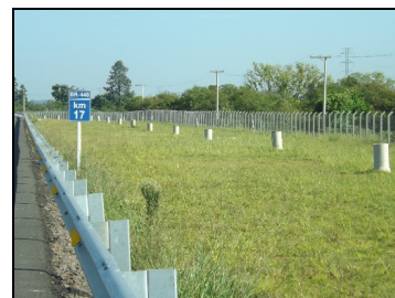
Figura 12: Vista geral da célula após cercamento.
