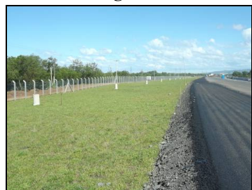
Figura 10: Célula após execução da cobertura final.
