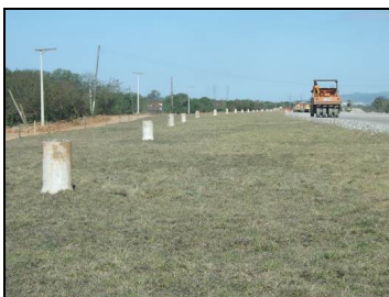
Figura 11: Vista geral da célula antes do cercamento.
