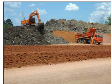
Figura 3: Disposição dos resíduos na célula.
