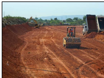
Figura 1: Compactação da base da célula.
