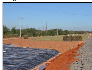
Figura 9: Componentes da cobertura final da célula.
