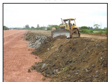
Figura 4: Adensamento dos resíduos com trator esteira.
