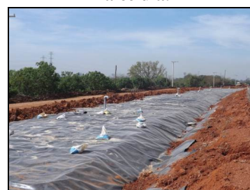
Figura 6: Instalação da geomembrana de PEAD.
