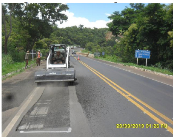
Figura 1 - Processo de Fresagem asfáltica. Fonte: Acervo do autor.
