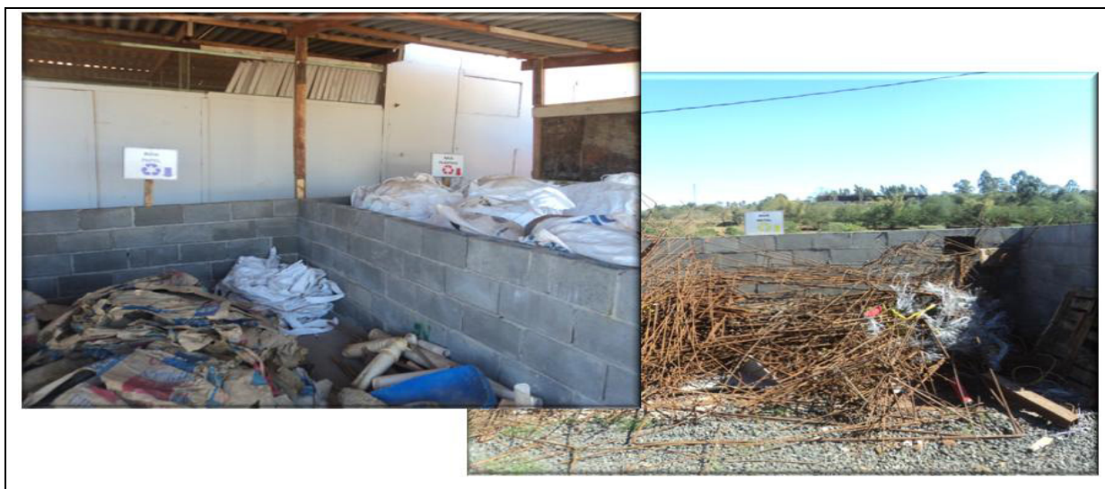
Figura 5: Baias para Armazenar os Resíduos. Fonte: Arquivo pessoal, 2013.
