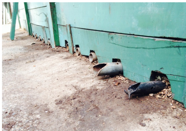
Figura 4: Coletores de chorume. Fonte: Autor do Trabalho.
