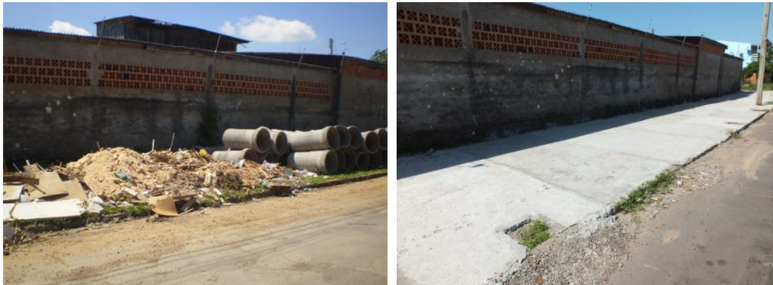
**Figura 2: Calçada externa da madeireira, comparação entre antes e depois. Fonte: Autora do Trabalho.**
