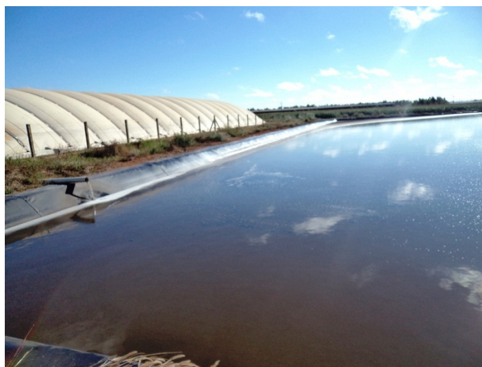
Figura 2: Lagoa para tratamento dos efluentes ao lado de um biodigestor.
