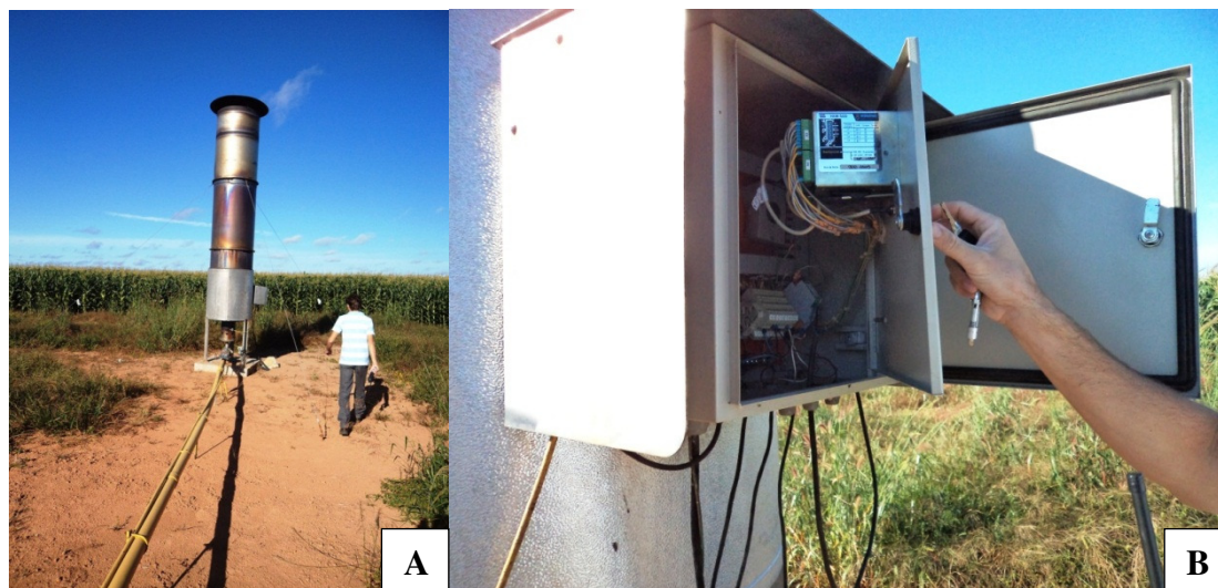
Figura 3: (A) - queimador utilizado para combustão do gás metano produzido no biodigestor. (B) - Aparelho que armazena os dados da quantidade de gás queimado.
