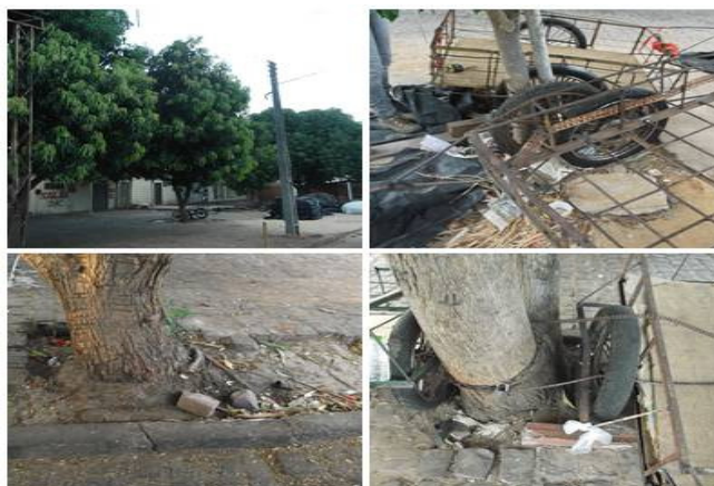
Figura 9: Canteiro de aeração obstruído Fonte: Pesquisa direta, 2012
