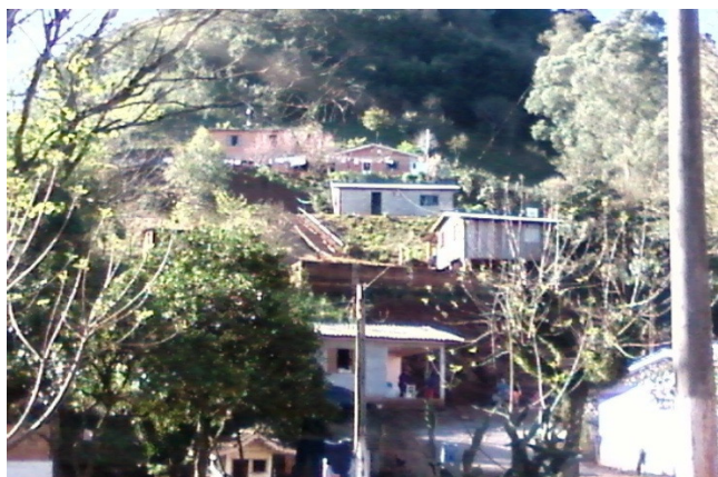
Figura 3: Bairro Primavera, localizado na cidade de Marau/RS, que abriga moradias construídas em morros altíssimos, que não oferece segurança nenhuma a quem mora ali.
