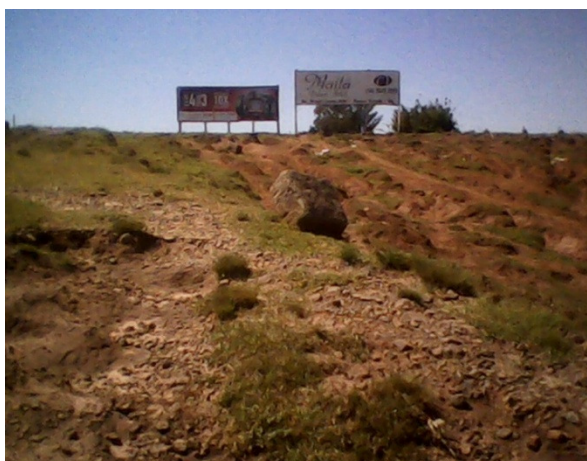
Figura 2: Demonstra a presença de voçorocas em trevo no município de Passo Fundo/RS.
