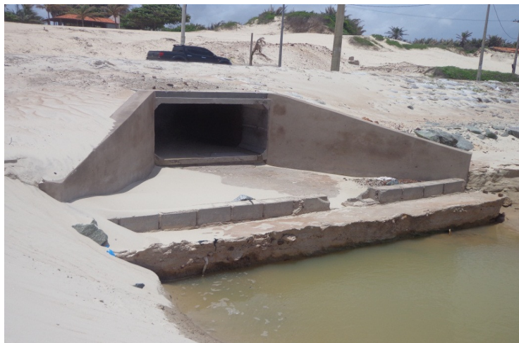
Figura 3: Exposição da drenagem.
