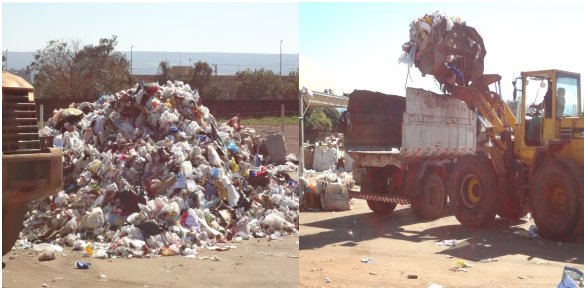
Figura 5: Estação de transferência e transbordo da Asa Sul Fonte: Registro fotográfico de campo.
