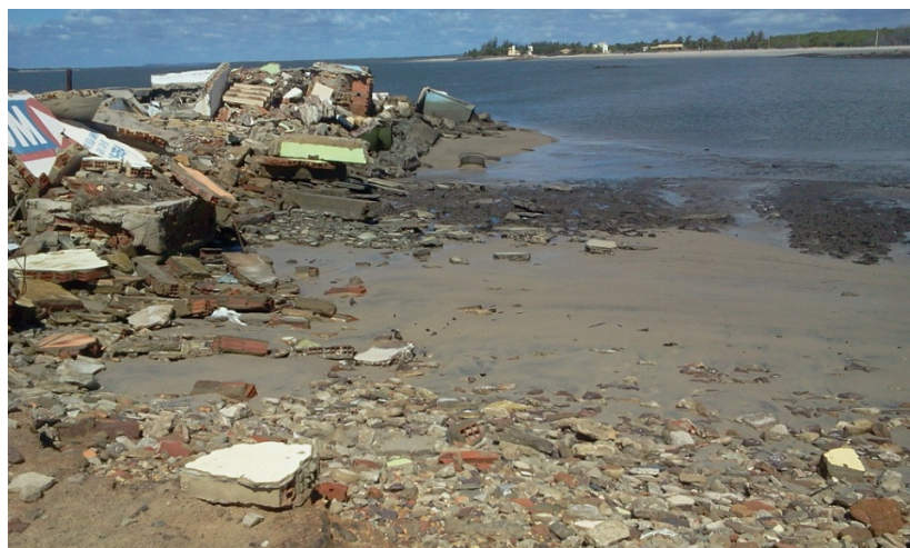
Figura 06: Resíduos sólidos da construção civil decorrente da ação do mar. Coordenadas: 680.897 m; 8.736.017. Fonte: SILVA et. al., 2013.
