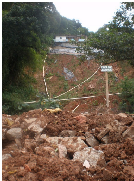
Figura 5: Casa construída em área de APP.
