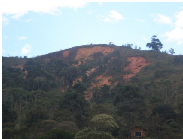
Figura 4: Queda de encosta no Bairro Campo Grande.
