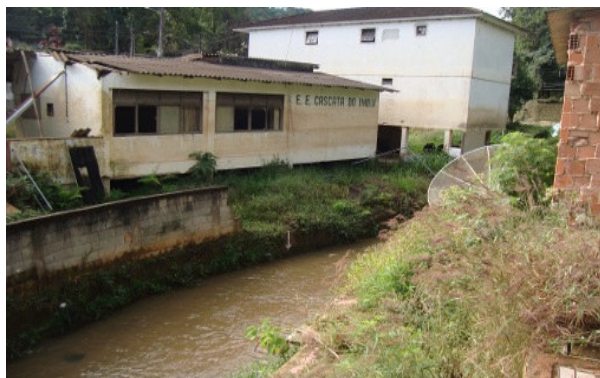
Figura 2 - Imagem do Colégio Estadual Cascata do Imbuí construído em área de APP. Fonte: (Gallo dos Santos, Danilo, 2012 Colégio Estadual Cascata do Imbuí
