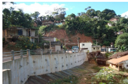
Figura 6- Muro de contenção no bairro Granja Florestal. Fonte: (Gallo dos Santos, Danilo, 2012 Granja Florestal
