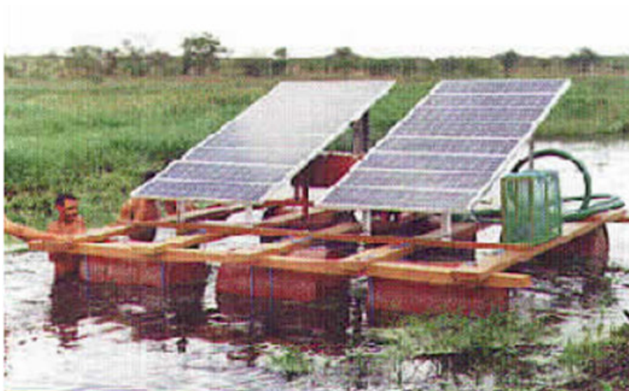
Figura 2: Sistema fotovoltaico de bombeamento de água para irrigação (Capim Grosso – BA) - Fonte: CRESESB - 2006.
