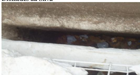
Figura 5 – Bueiro entupido junto à parada. Fonte: Diomedes da Silva
