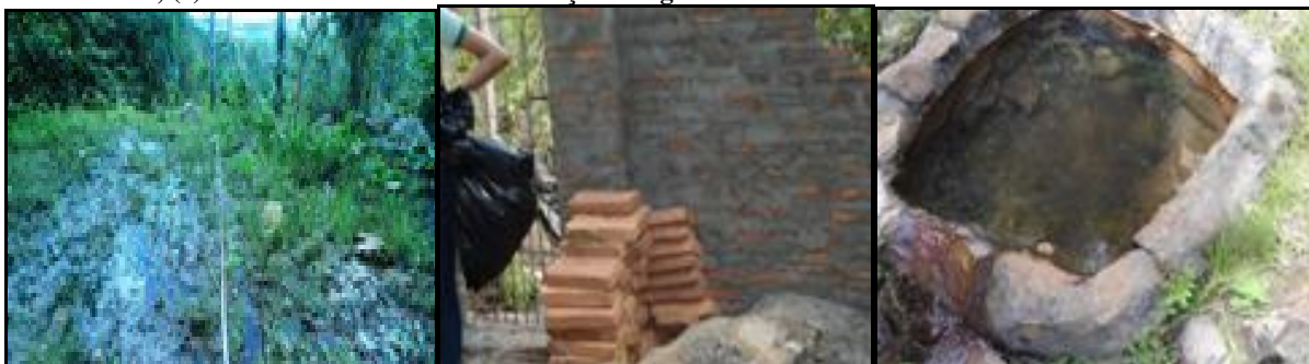
Figura 3: (a) Solo encharcado típico de Brejos de Altitude; (b) Muro que separa a parte de captação de água das demais áreas; (c) Barramento utilizado na retenção de água de nascentes.
