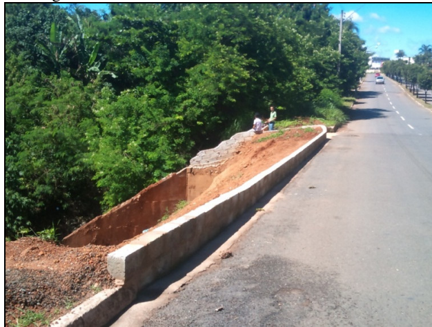
Figura 02. Solo exposto às margens de Avenida em Aparecida de Goiânia próxima ao Córrego do Almeida com grande erosão causada por lixiviação.
