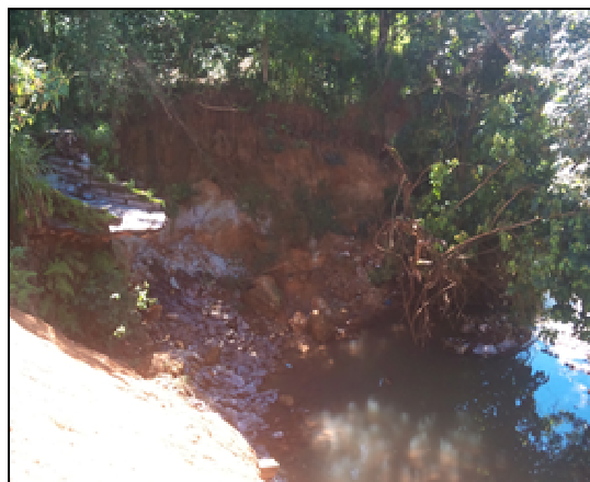
Figura 03. Erosão com grande perda de solo e consequente assoreamento do Córrego do Almeida, devido à deposição de material lixiviado.
