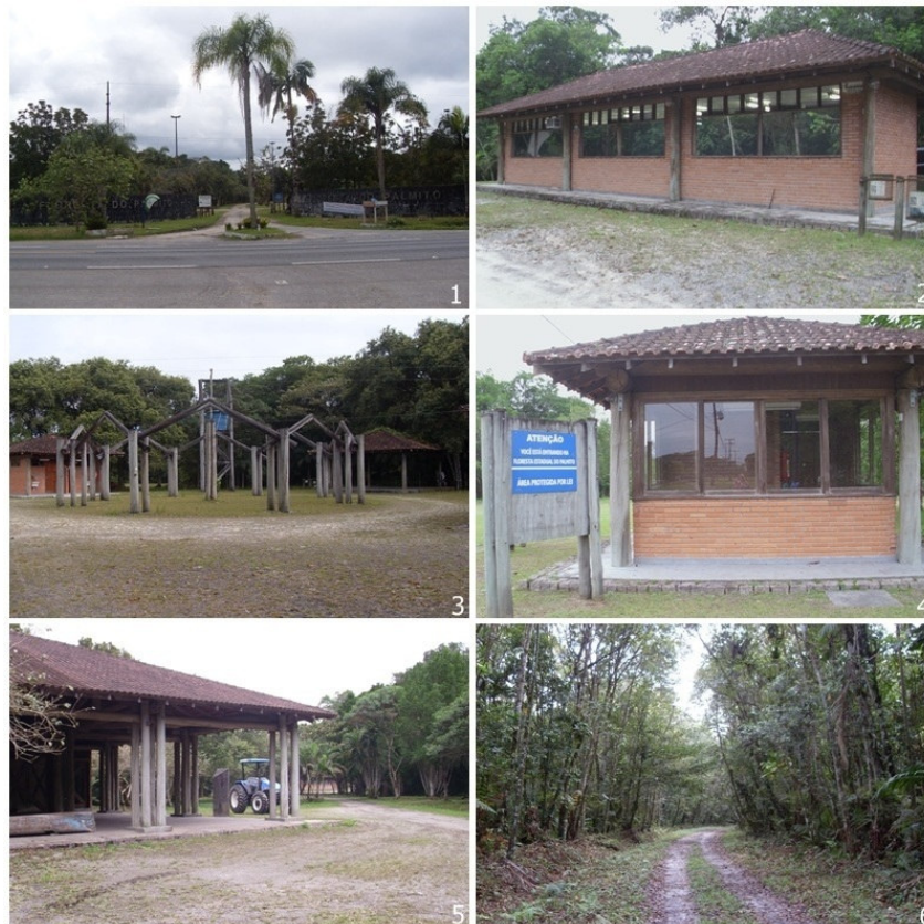
Figura 1: Vistas parciais da infraestrutura da FEP. (1) Entrada da UC; (2) Laboratório; (3) Sanitários; (4) Guarita; (5) Sala para eventos e trator; (6) Estrada interior. Fonte: Autores do trabalho, 2011.
