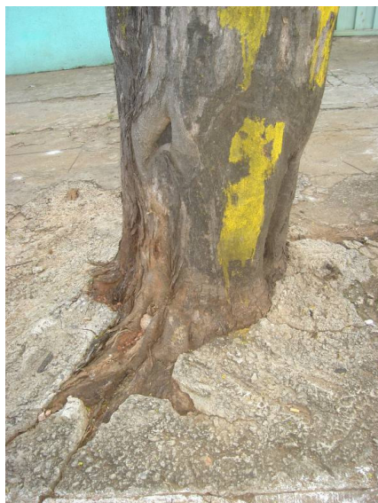
Figura 8: Ausência de área permeável, soerguimento da via de passeio e atos de vandalismo sobre os indivíduos arbóreos que compõe a arborização local. Fonte: Autora
