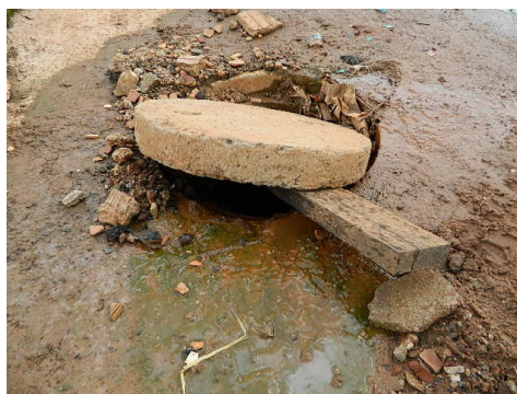
Figura 7: Boieiro entupido / Fonte: Os autores
