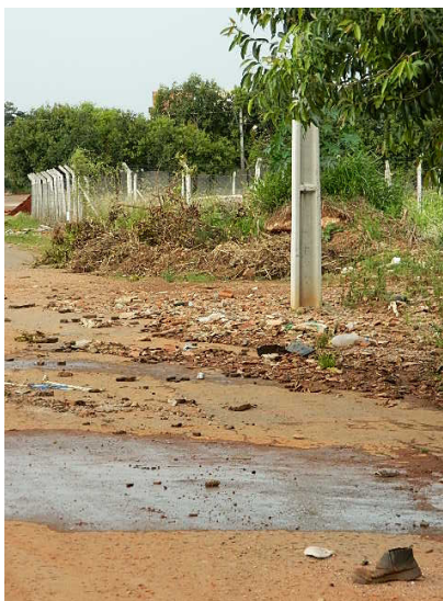
Foto 3: Sedimentos transportados por enchente / Fonte: Os autores.
