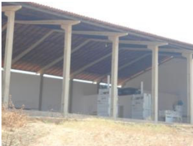
Figura 3: Galpão destinado aos catadores com os equipamentos. Fonte: Pesquisa Direta, 2012.
