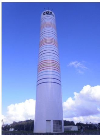
Figura 7: Torre de distribuição EACH/USP, em 2012
