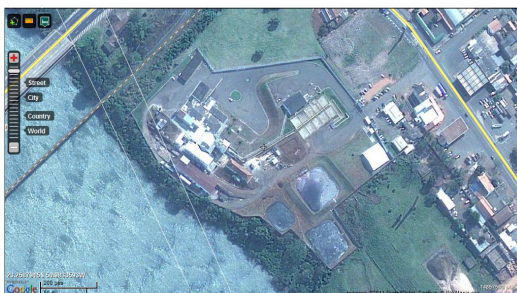
Figura 1: Imagem por satélite do Frigorífico Frigo Star.
