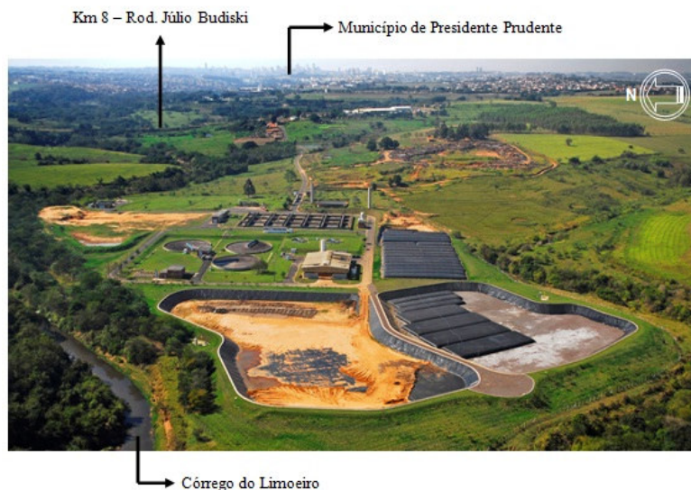
Figura 1: Estação de tratamento de esgotos – ETE-Limoeiro. Fonte: (Sabesp, 2011)
