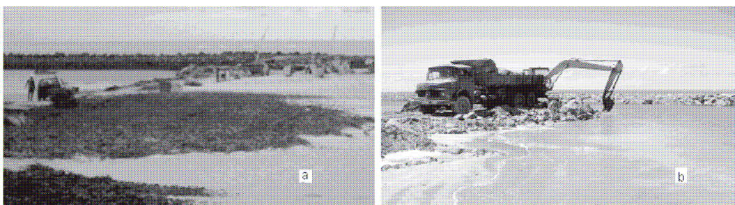
Fotos da Praia de Candeias, Jaboatão dos Guararapes – Pernambuco: (a) espigão coberto pela areia da praia e quebra-mar ao fundo (ago/2004) e (b) retirada do espigão perpendicular a praia, permitindo a circulação da água na área interna do quebra-mar.
