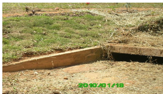
FIGURA 3 - Talude revegetado. (Janeiro - 2010)
