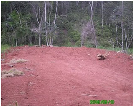
FIGURA 4 - Barragem com solo desnudo. (Agosto de 2009)
