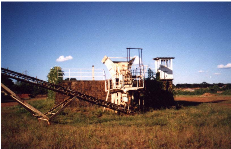
Figura 1. Usina de Reciclagem de RCC.
